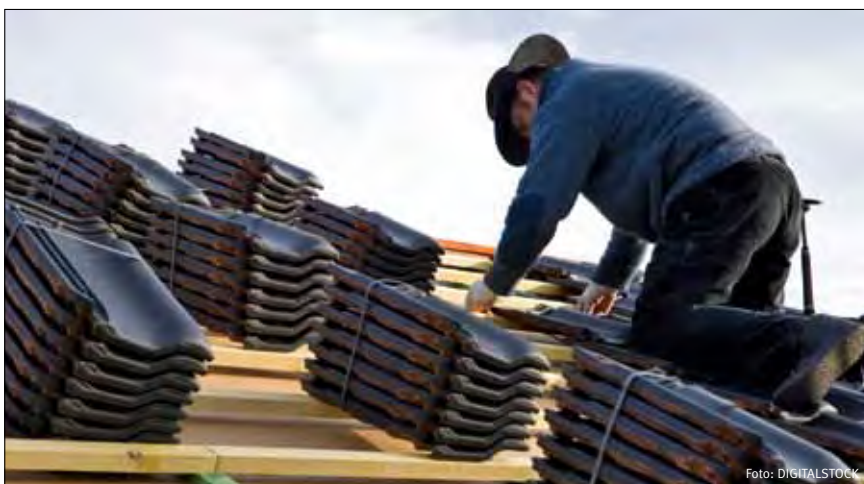
Im Dachdeckerhandwerk führt der Mindestlohn zu einer Fachkräfteintensivierung.
