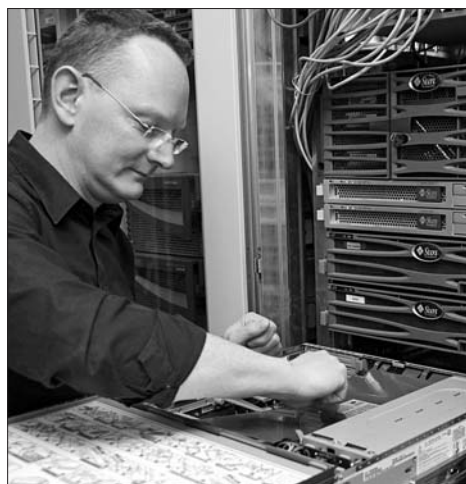
Im Serverraum der EDV
